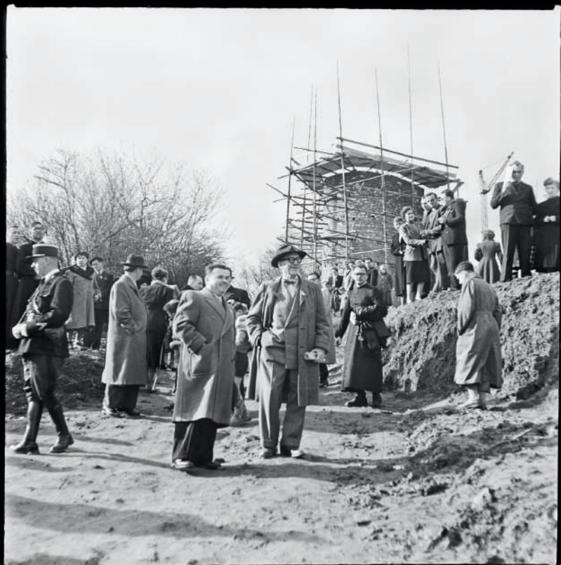
La chapelle en construction & son architecte, par Charles Bueb
