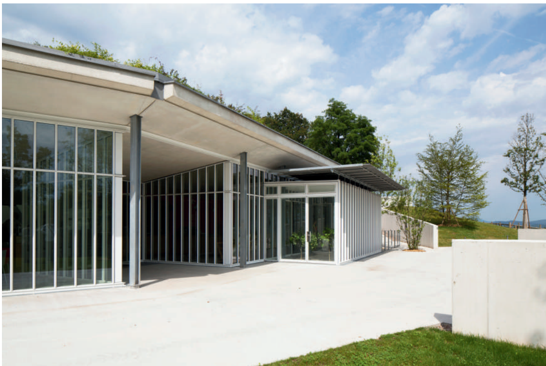
La porterie, accueil du site
